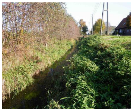
Oberhalb Kläranlage Fürstenaue
