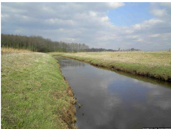
Südradde km 4,4 : strukturarmes Ufer durch Uferbefestigung
