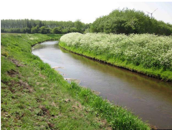
Ohe bei Beddenberg: Regelprofil durch Uferbefestigung
