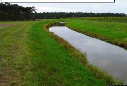
Siede Unterlauf-fehlende Ufergehölze
