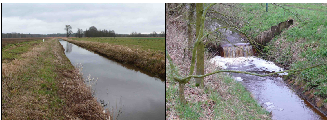
Wulbeck, uh. Grasbruchdamm
