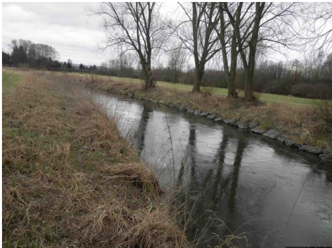
↓ Die lineare Festlegung der Ufer bis an die Böschungsbasis (Stat.: 211+900) fixiert das Gewässer kanalartig. Bereits die übermäßige Korngröße läßt den umfassenden Ausbau erkennen.
