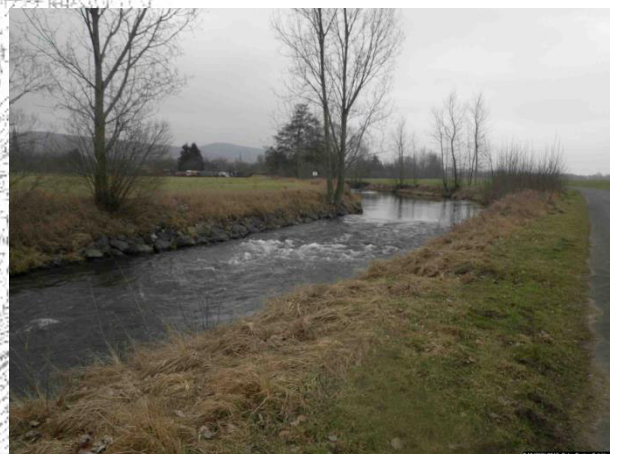
↓ Mit Grobsteinen festgelegtes Prallufer
