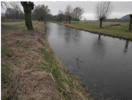
↑ Kanalisierte Strecke bei 201+800
