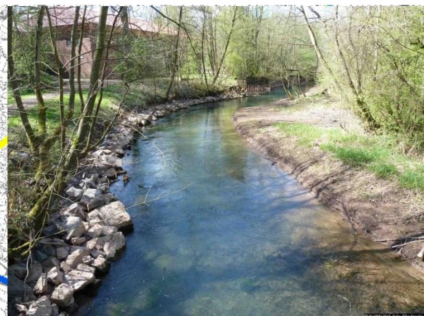
↑ In der Ortslage Rhumespringe ist das Gewässer streckenweise massiv festgelegt. Der Umfang der Entnahmemenge zur Trinkwassergewinnung erscheint evtl. störend.
