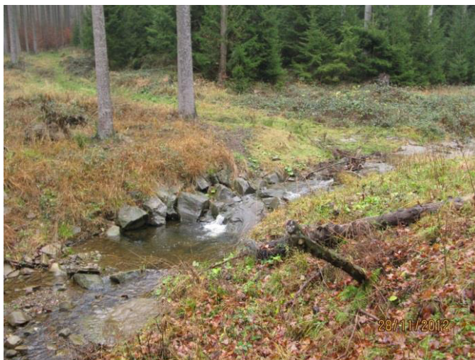
↑ Furt mit Sohlabstürzen im Unterwasser
