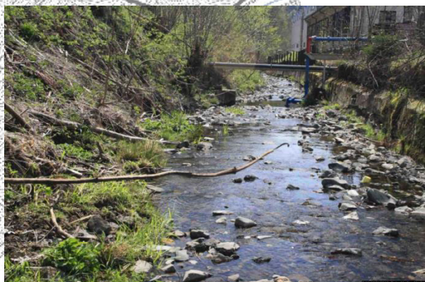
↑ Einseitige Ufersicherung in der Ortslage bei Stat 5+200
