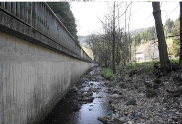
↓ Sicherung der Landesstraße bei Stat 9+900
