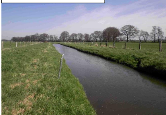
Hache Unterlauf - Uferabbrüche durch Erosion
